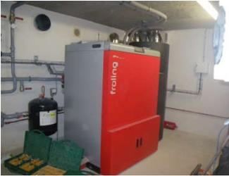
Tout le système de chauffage a été modifié en 2011 pour des raisons de sécurité et d'écologie. C'est à présent une chaudière à granulés de bois (pellets) et des panneaux solaires qui produisent chauffage et eau chaude pour l'ensemble de l'hôtel. Pour information, l'établissement ne compte pas
