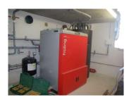
Tout le système de chauffage a été modifié en 2011 pour des raisons de sécurité et d'écologie. C'est à présent une chaudière a granulés de bois (pellets) et des panneaux solaires qui produisent chauffage et eau chaude pour l'ensemble de l'hôtel. Pour information, l'établissement ne compte pas moins de 75 radiateurs dans lesquels circulent environ 600 litres d'eau (chauffés en partie par les panneaux solaires). La réserve de granulés est de plus de 11 tonnes.
